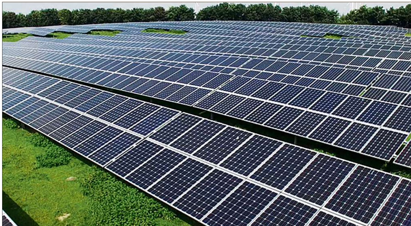
Die GVS-Unternehmensgruppe freut sich über den Zuschlag für den Bau einer Photovoltaikanlage.
