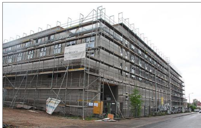
Der Gebäudekomplex wirkt an der Seite der Wasenstraße sehr massiv.
