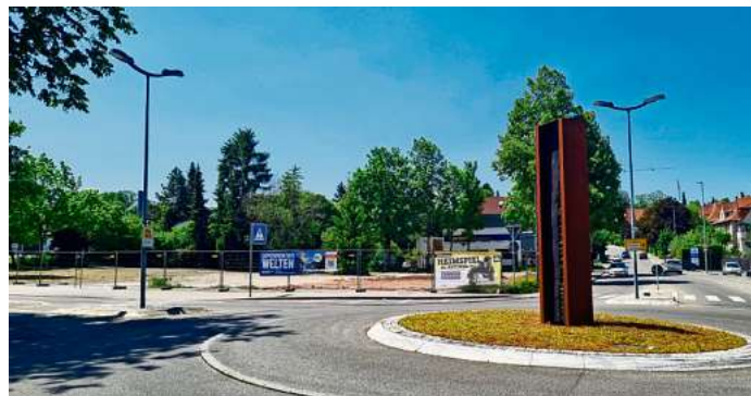
Das ehemalige Breucha-Areal (hinten) am Kreisverkehr Heerstraße/Stadionstraße wird neu bebaut.
